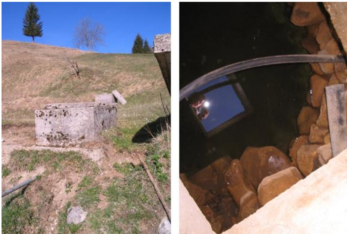
Slika 16: Zajetje izvira na Gorjuzah zunaj (levo) in znotraj (desno) (Izdelala: Elizabeta Mavri )
