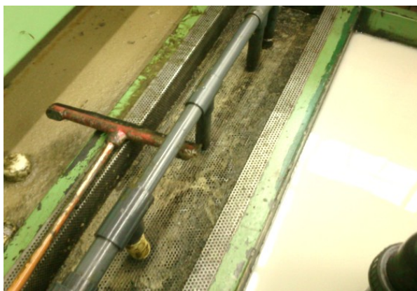
Slika 36: Vtok v usedalnik
