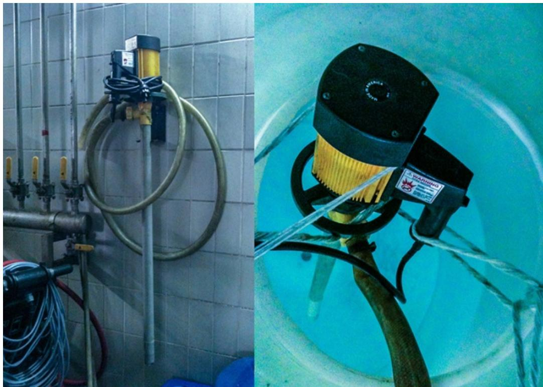
*Slika 9: Prenosna črpalka (levo) in nameščena na vrh reaktorske posode (desno)*
