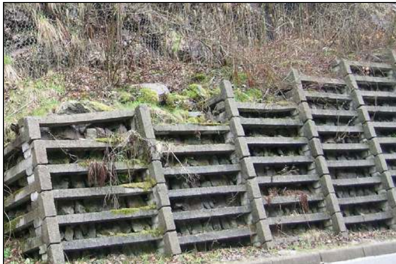
Slika B – 3: Montažna konstrukcija (okolica Tolmina)
