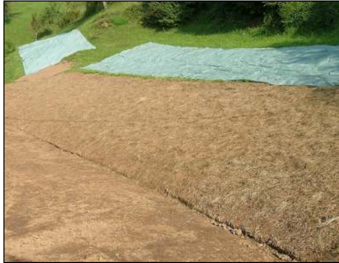
Slika A – 5: Lokalna zemeljska dela na območjih, kjer so ogroženi objekti (po izvedbi ukrepa) (Ribičič in sod., 2005b, str: 22)
