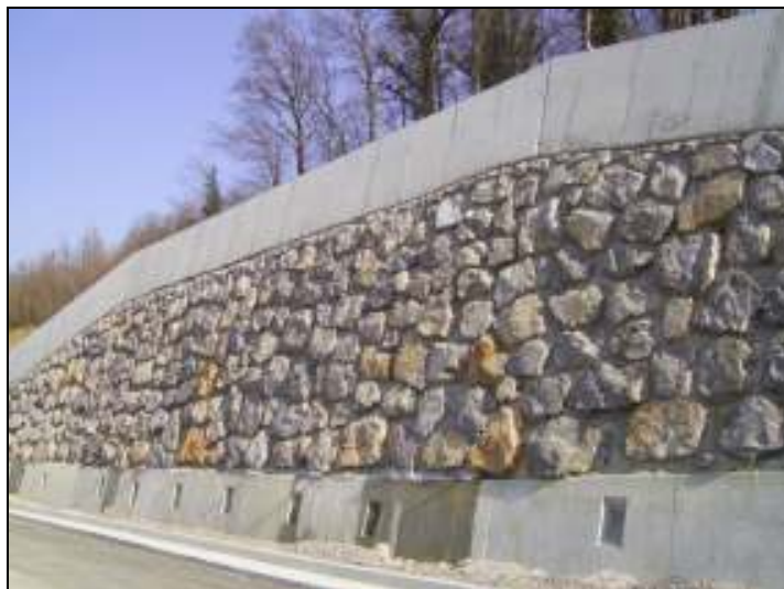
Slika B – 11: Sidrana pilotna stena – pred končno situacijo (hitra cesta Razdrto – Podnanos)
