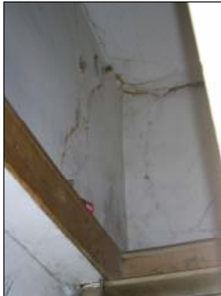
Slika E – 12: Razpoke znotraj objekta
