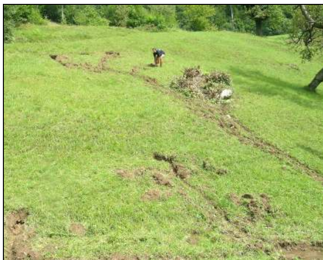
Slika A – 2: Odvajanje voda s telesa plazu s površinskimi jarki (Ribičič in sod., 2005b, str: 20)
