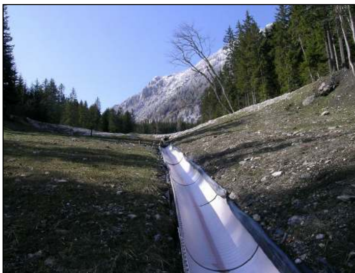
Slika A – 1: Preusmeritev dotokov površinskih voda s telesa plazu (Ribičič in sod., 2005b, str: 19)
