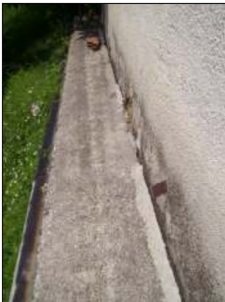
Slika F – 2: Odstopanje pločnika od gospodarskega objekta
