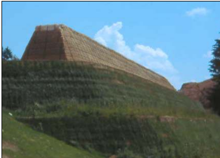
Slika B – 8: Armirana zemljina ( http://www.fgg.uni-lj.si/kmtal/Gradiva%20za%20vec%20predmetov/Skripta%20Majes/Uvodno%20predavanja%20(1)%20-%20izredni%20%9Atudij.pdf )
