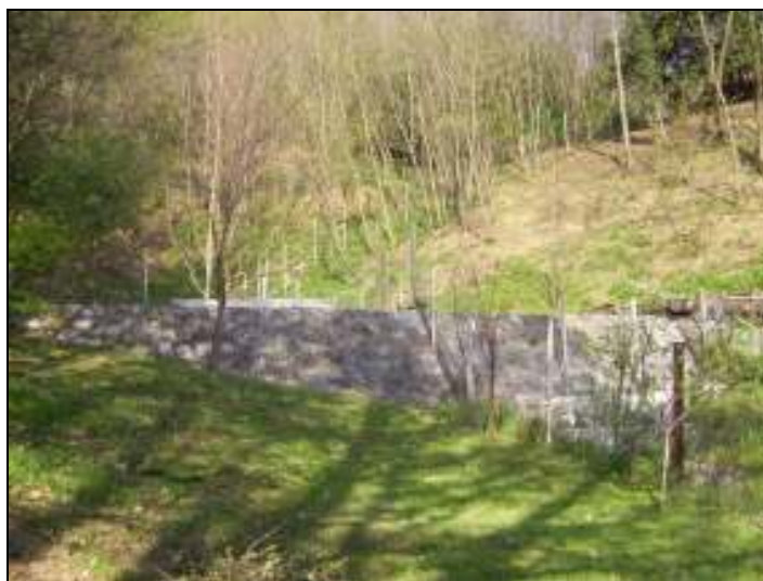
Slika B – 4: Kamnita zložba s cementnim vezivom (Šempeter pri Gorici)
