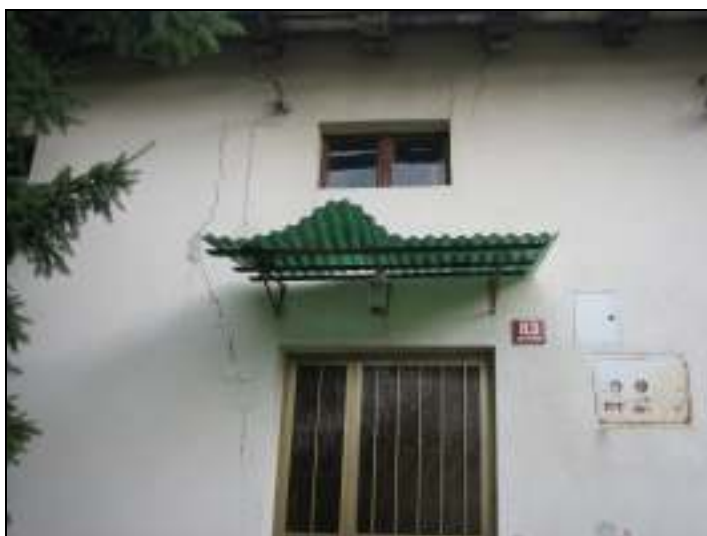
Slika D – 2: Razpoke nad vhodom
