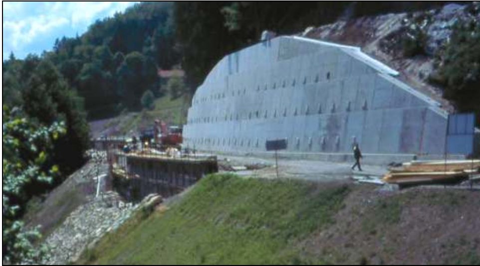
Slika B – 7: Sidrani zid ( http://www.fgg.uni-lj.si/kmtal/Gradiva%20za%20vec%20predmetov/Skripta%20Majes/Uvodno%20predavanja%20(1)%20-%20izredni%20%9Atudij.pdf )
