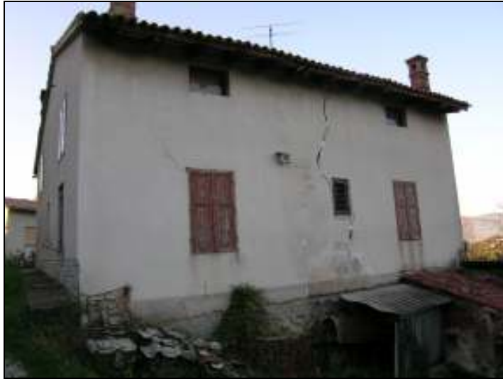
Slika D – 3: Zadnji del objekta z veliko razpoko
