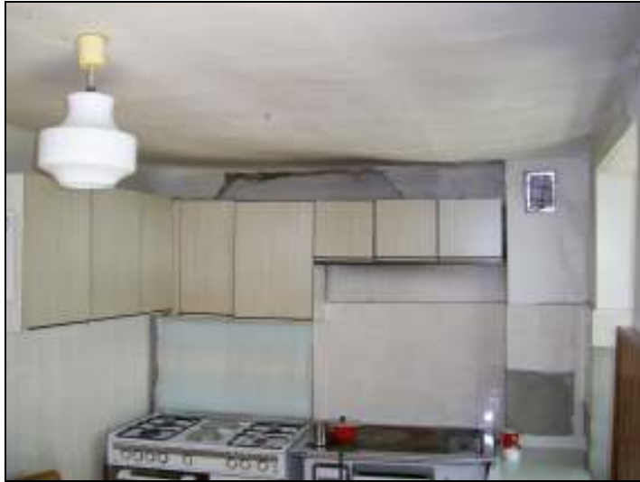
Slika E – 11: Razpoke znotraj objekta in useden strop
