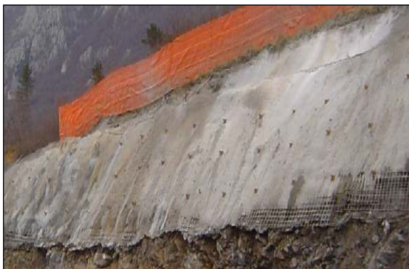
Slika B – 10: Sidrana stena iz brizganega betona (hitra cesta Razdrto – Podnanos)
