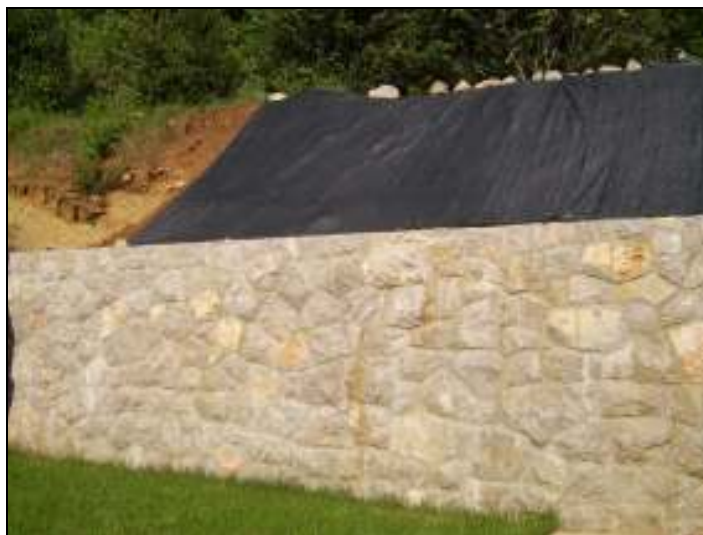
Slika B – 1: Kamniti zid s cementnim vezivom (Solkan)
