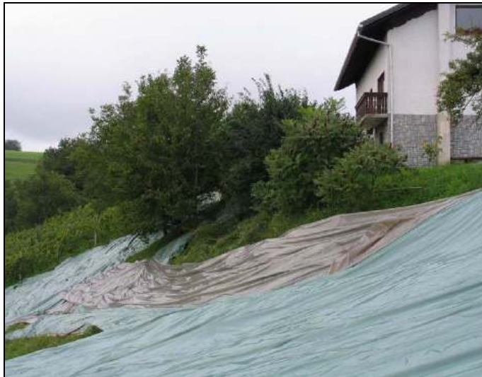
Slika A – 3: Prekrivanje manjšega plazu s folijo za preprečevanje omočenja plazine (Ribičič in sod., 2005b, str: 21)
