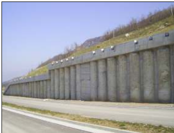
Slika B – 11: Sidrana pilotna stena – pred končno situacijo (hitra cesta Razdrto – Podnanos)
