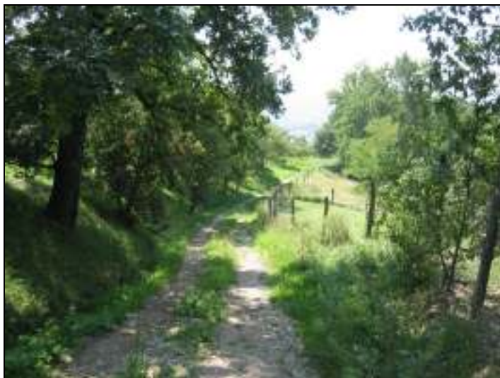
Slika 21: Zasilna cestna povezava z neurejeno odvodnjo
