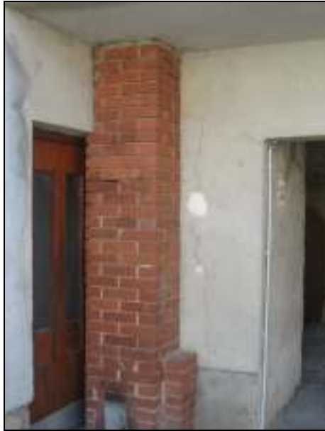
Slika D – 5: Razpoke pri glavnem vhodu
