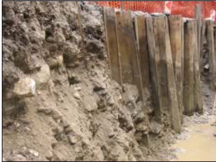
Slika B – 13: Zagatne stene (Solčava)
