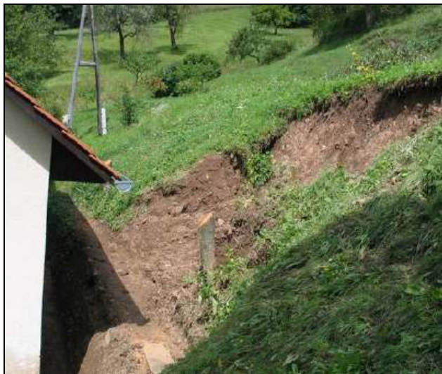
Slika A – 4: Lokalna zemeljska dela na območjih, kjer so ogroženi objekti (pred izvedbo ukrepa) (Ribičič in sod., 2005b, str: 22)
