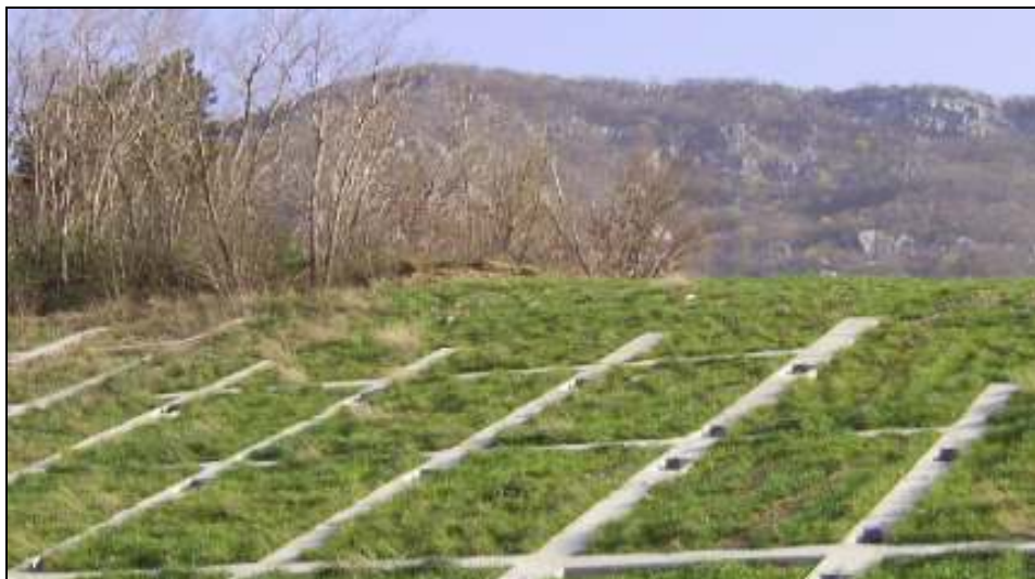
Slika B – 9: Betonska armirana rešeta (hitra cesta Razdrto – Podnanos)
