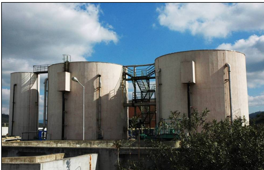
Slika 40: Zgoščevalnik blata (levo) in primarno ter sekundarno gnilišče CČN Koper
