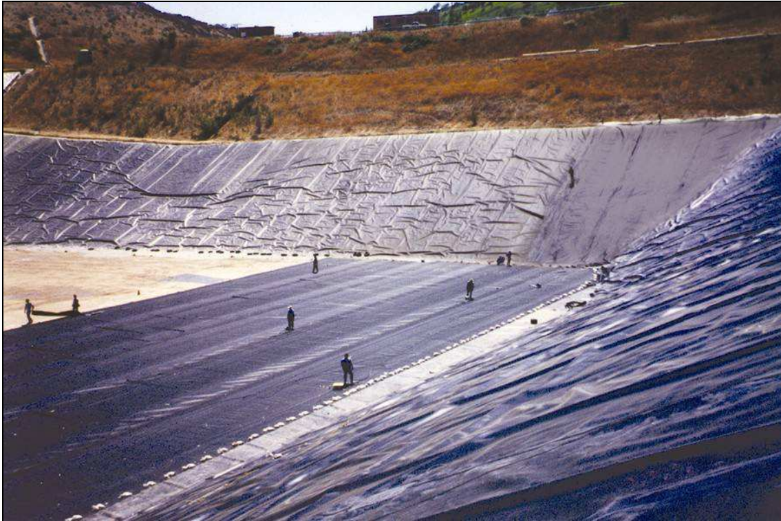
Slika 2: Tesnilna folija za tesnenje odlagališnega dna [8]
