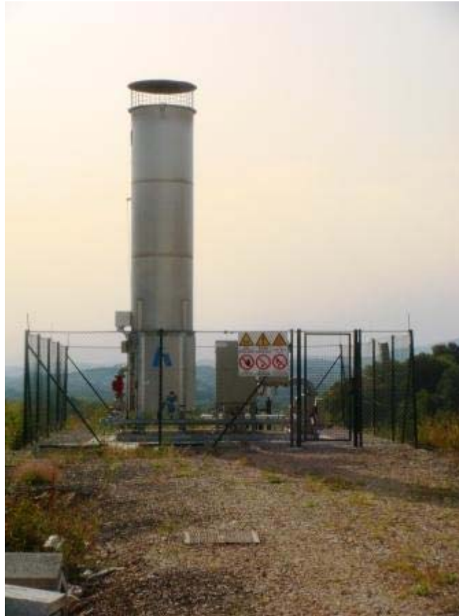
Slika 8: Bakla za sežig odlagališčnega plina (foto: Ivana Likar)
