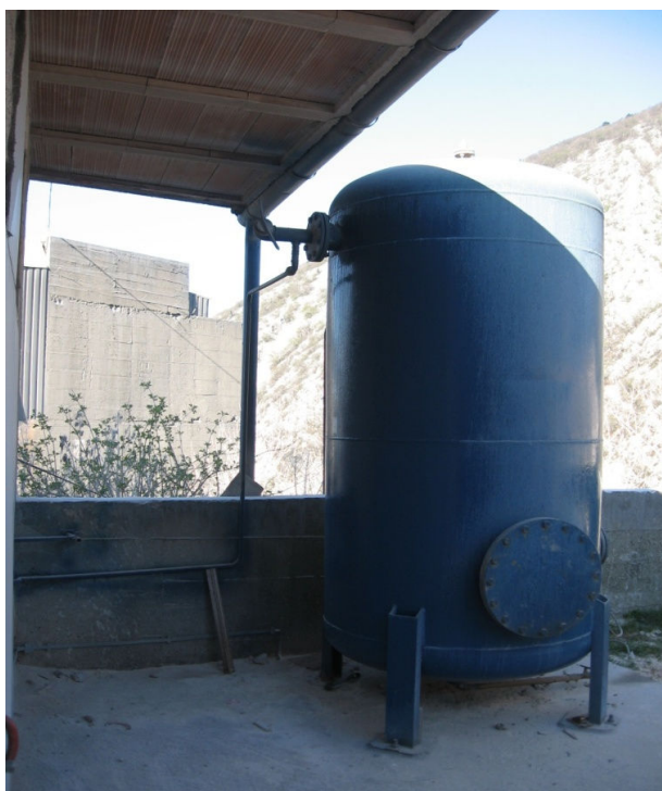
Slika 22: Vertikalni tip tlačne posode na območju kamnoloma
