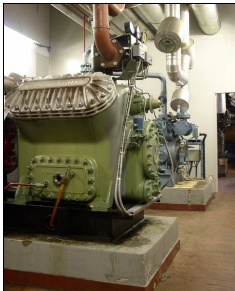
Slika 12: Hladilni agregati
