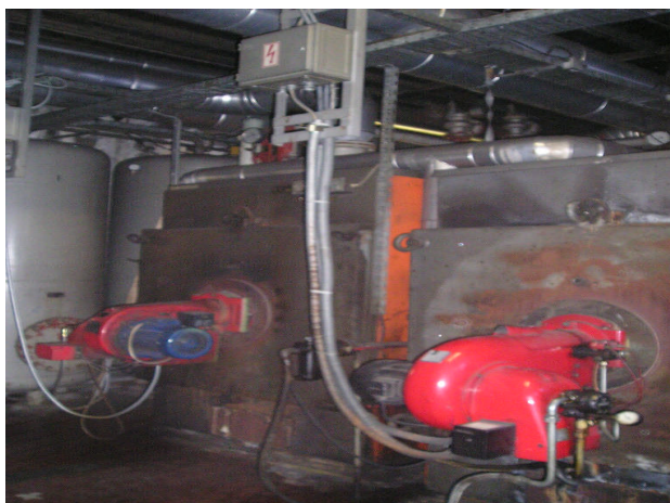
Slika 3: Obstoječi ogrevalni sistem
