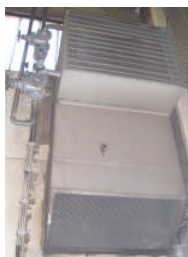
Slika 9: Kalorifer v proizvodni hali
