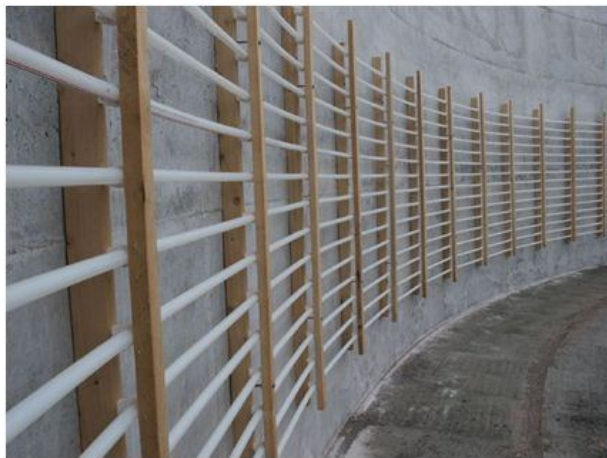
Slika 22: Grelci na zidni površini digestorja (prazen, v izgradnji) (Grelci, 2008)
