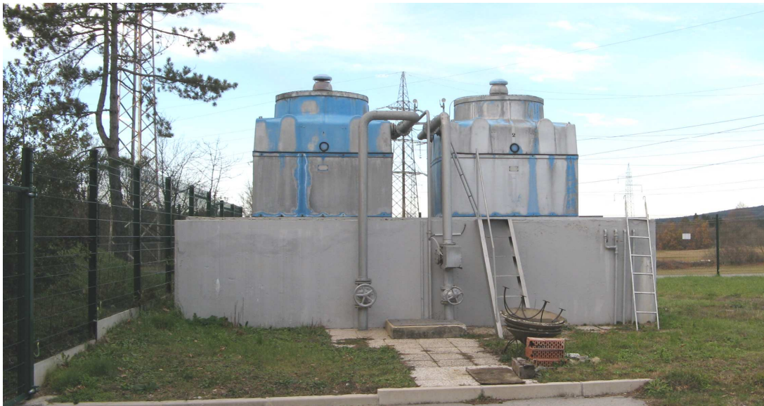
Slika 11: Hladilni stolpi nad bazenom
