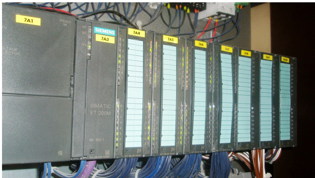
Slika 18: Decentralizirani sistem na katerega je priključen dajalnik impulzov
