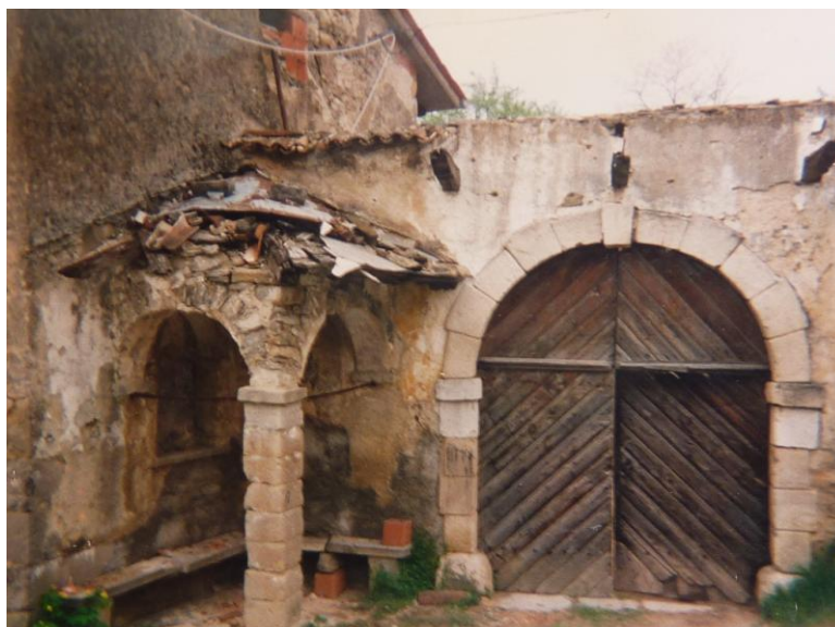
Slika 21: Vhod in kapelica s portonom pred začetkom obnove stavbe leta 1994
