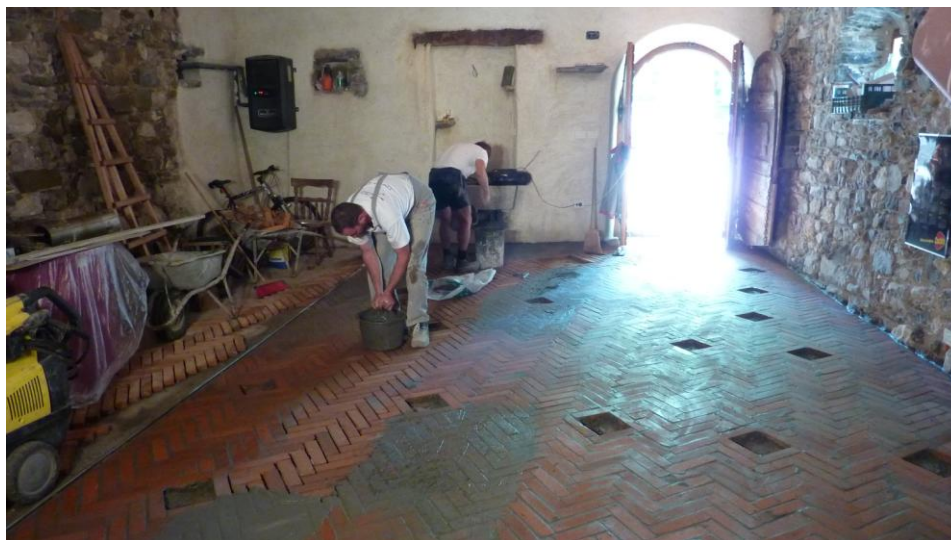
Slika 26: Faladur – prostor za predelavo pridelkov ter spravilo vinogradniške opreme med obnovo
