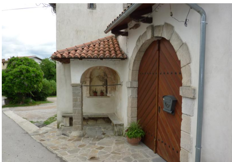
Slika 20: Vhod v domačijo s kapelico in portonom po obnovi
