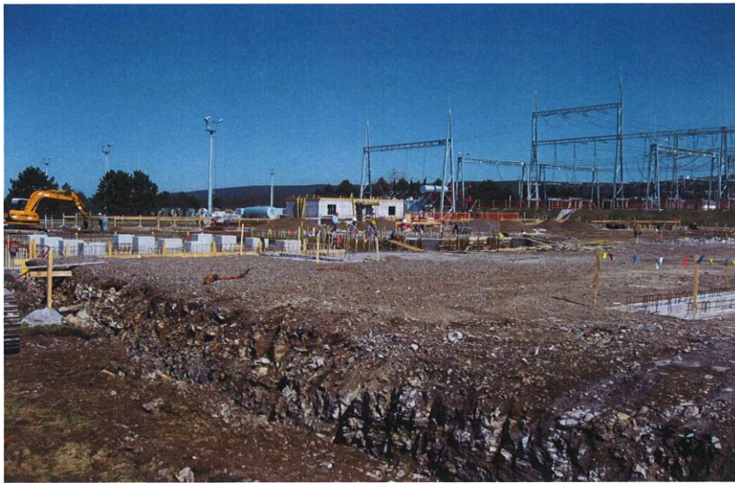
Slika 6: Gradbišče prečnega transformatorja (Arhiv, 2010)
