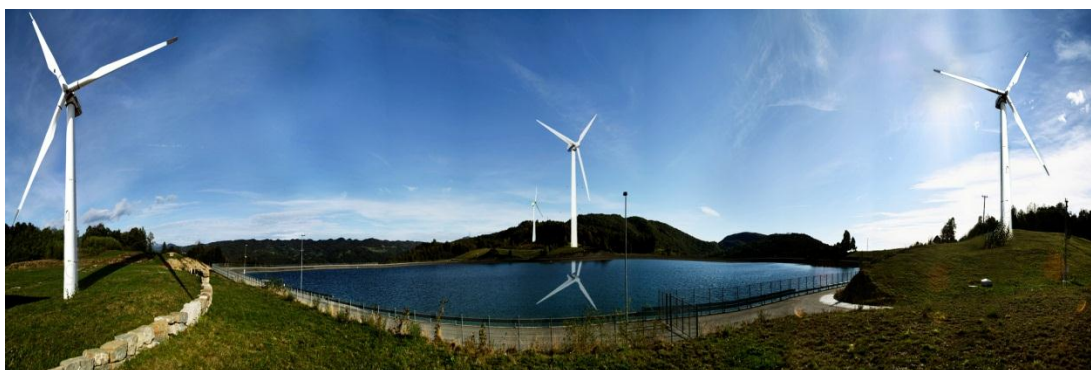
Slika 15: Predvidena mesta postavitve vetrnih turbin
