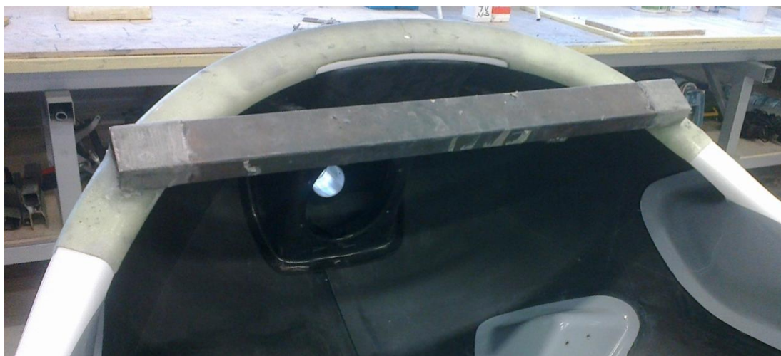
Slika 14: Priprava za vgradnjo nosilca tečajev
