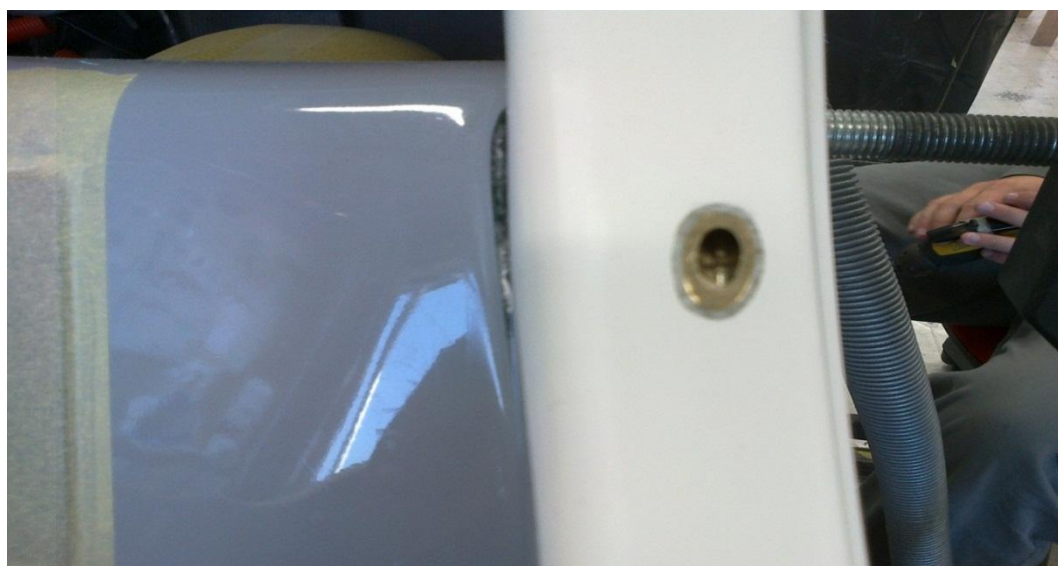
Slika 31: Končan postopek vgradnje puše
