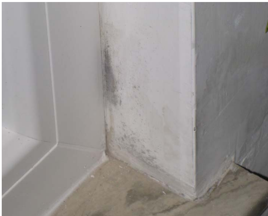
Slika 5: Primer pojava plesni (Lastna fotografija)
