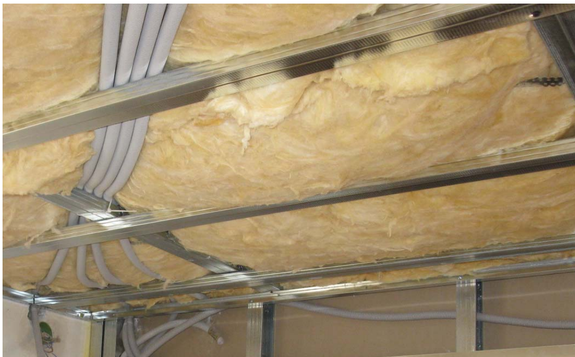
Slika 3: Izvedba izolacije stropa k podstrešju (Lastna fotografija)
