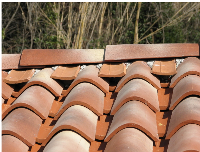
Slika 4: Star način pokrivanja z malto (Goriške opekarne, 2011)
