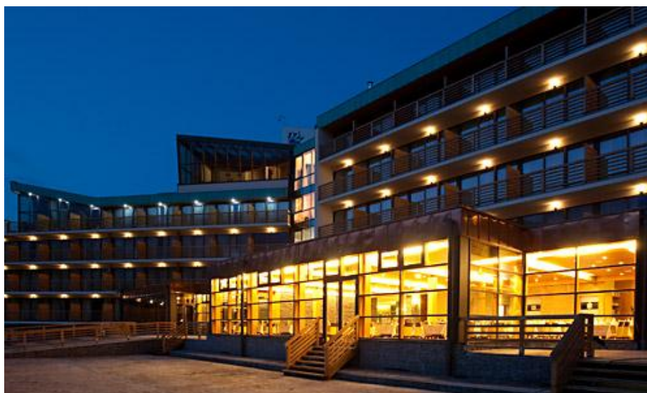
Slika 1: Energijsko varčen Park Hotel Bohinj (Park Hotel Bohinj, 2013)
