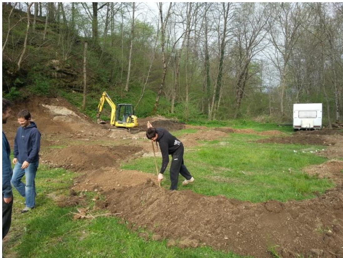
Slika 3: Gradnja »pump« proge ob Soči
