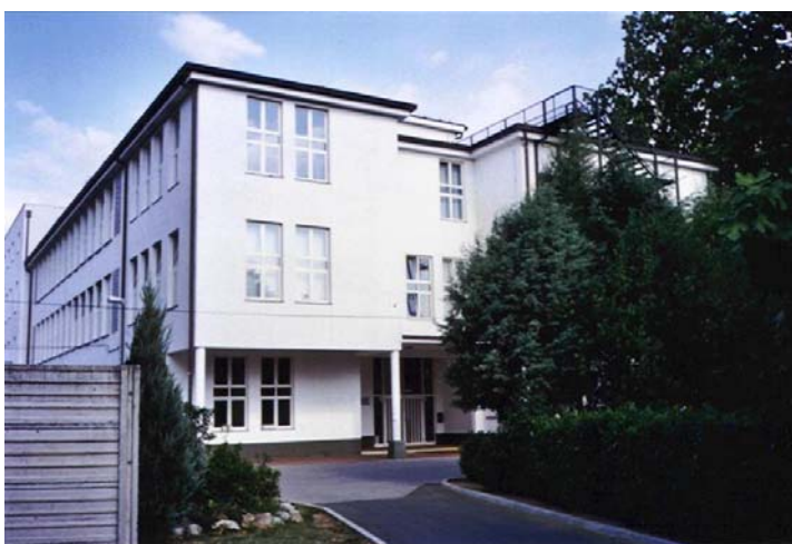
Slika 2: Zahodna fasada OŠ Ivana Roba po prenovi in dograditvi
