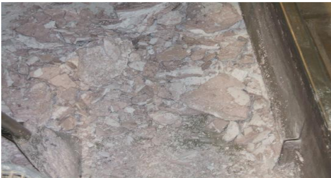
Slika 13: Plasti usedlin na dnu zbiralnega bazena
