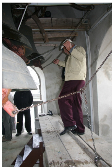
Slika 12: Namestitev vzvodov pri vodoravni postavitvi zvonov (Zasavska Sveta gora, 8. 6. 2008, Gor., foto: Mojca Kovačič)
