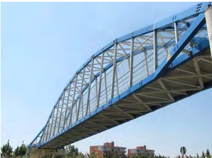
Lleida Pedestrian Footbridge, Lleida, Spain, 2004
