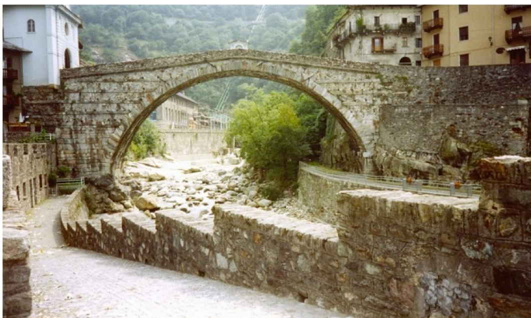
Fig 1.4 - San Martino Bridge, Val d'Aosta, Italy
