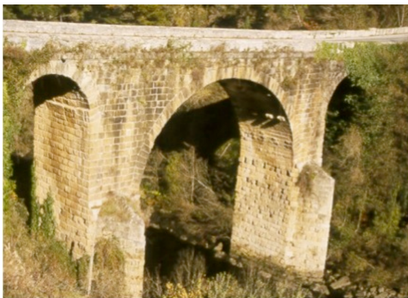
Fig. 1.1 - Bibey bridge, Galizia, Spain
