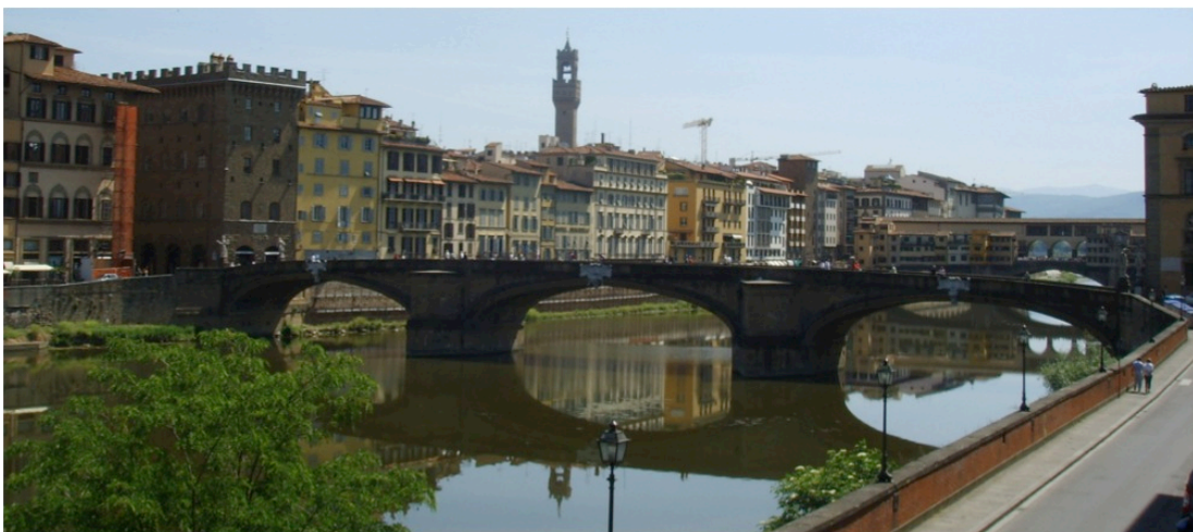
Fig 1.9 - Trinità Bridge, Firenze, Italia.
