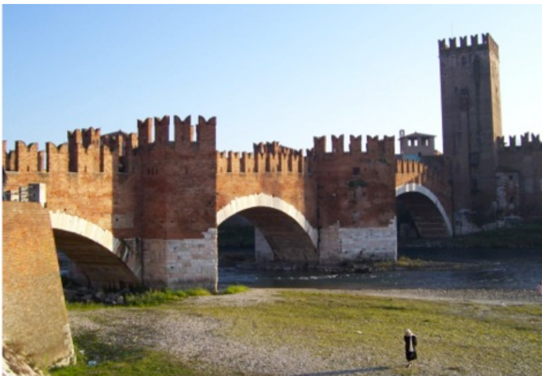
Fig 1.7 - Ponte Scaligero, Verona.
