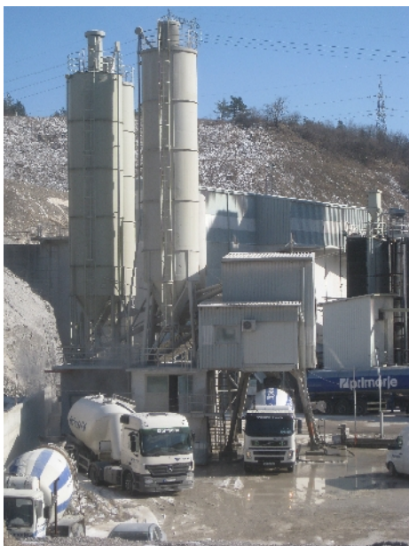
Slika 5: Betonarna za mešanje betonov
