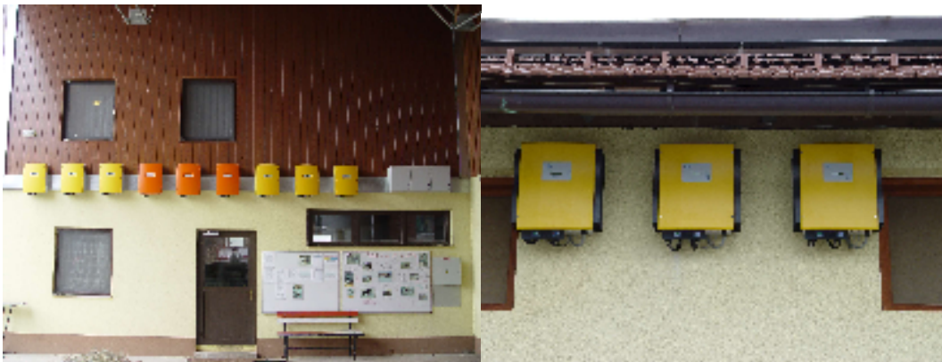
Slika 8.9 Prva skupina razsmernikov z DC spojiščem in druga skupina razsmernikov
