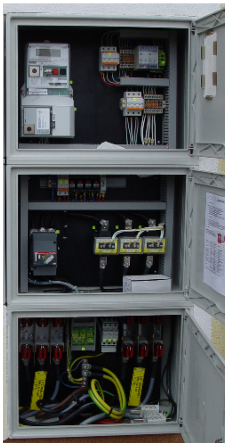
Slika 8.13 Merilno in ločilno mesto
