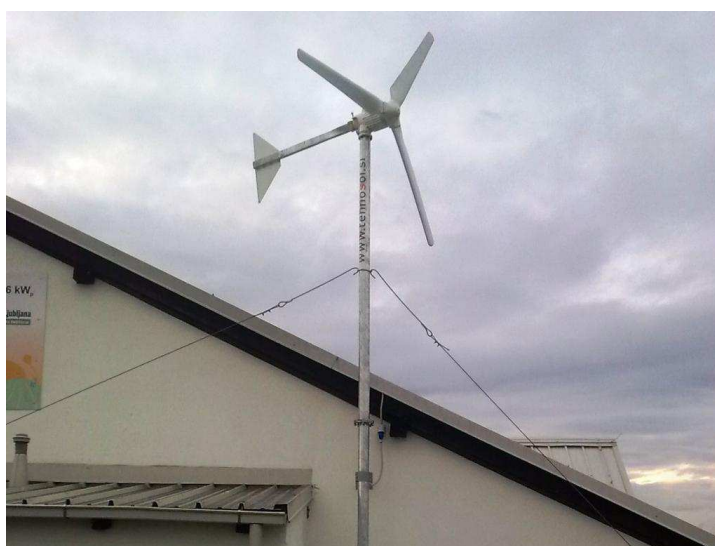
Slika 27: Vetrnica prtrjena na stanovanjsko hišo (Lontech, 2013)
