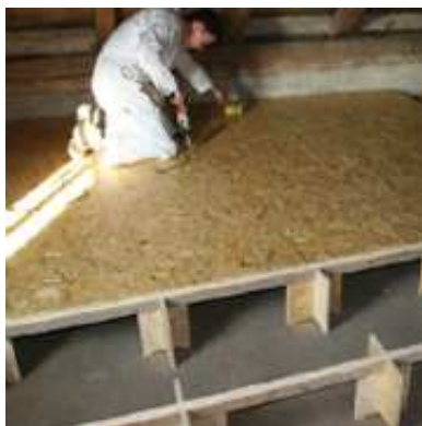
Slika 8: Postavitev lesene konstrukcije (Ekoprodukt, 2014)
