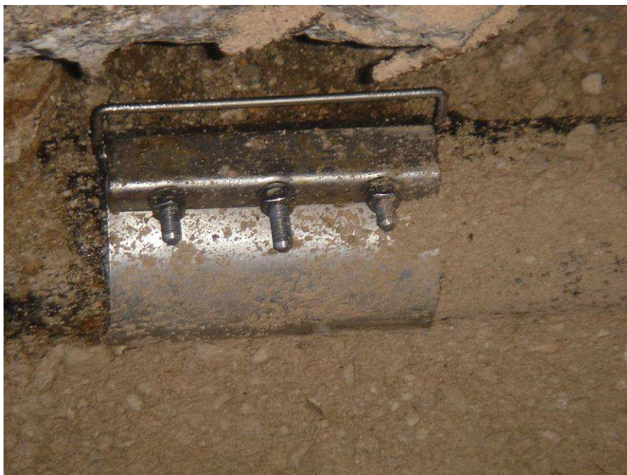
Slika 21: Zatesnitev puščanja z objemko
