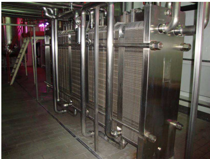
Slika 19: Toplotni prenosnik za pasterizacijo
